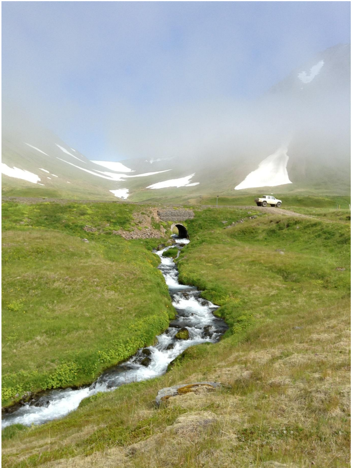
Mynd 15. Horft upp eftir ánni. NAVE/BÞ©25.7.2013.
