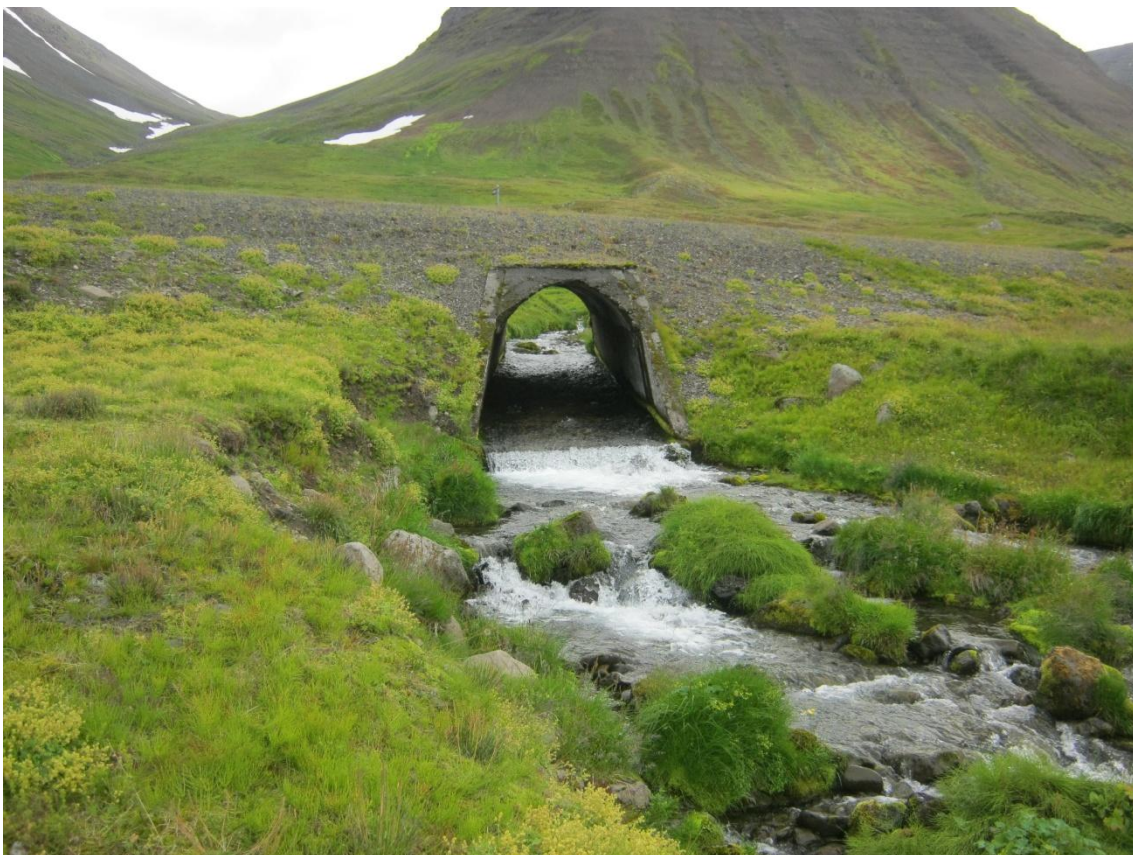
Mynd 6. Hólsá, mynd tekin fyrir neðan Flateyjarveg. NAVE/Gallo ©29.8.2013. Ræsið í gegnum Flateyjarveg er steypt ræsi með steyptum botni.
